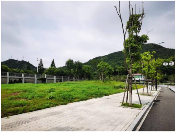
道路边坡植被
